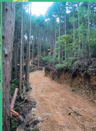
作業道開設状況
